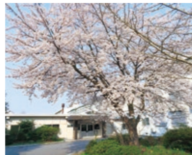
鶴峰寮管理棟玄関
