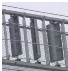
図2 地吹雪による視程障害対策用風車
