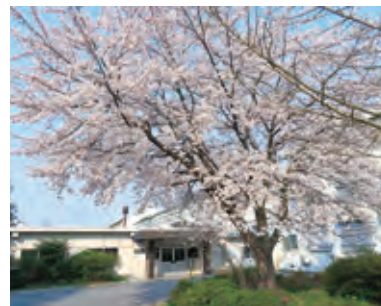
鶴峰寮管理棟玄関
