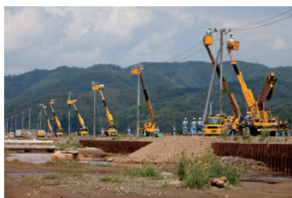
図2 津波被災地の復旧工事
