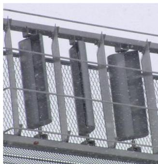
図2 地吹雪による視程障害対策用風車
