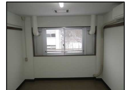
寄宿舍第7寮改修(Ⅰ期)
