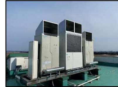
テクノセンター エアコン更新
