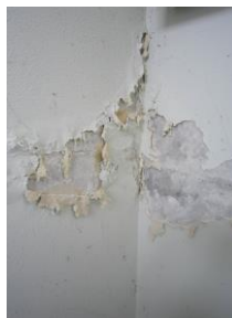
外壁からの漏水
