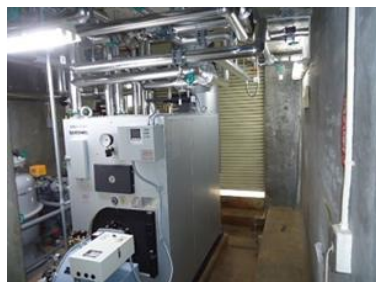
寄宿舍ボイラー更新
