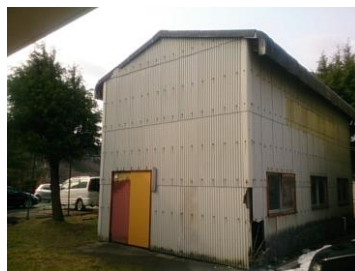
実験廃水処理施設
