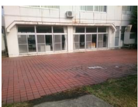
食堂前のテラス。十分に利用されていない
