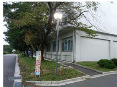
構内外等改修 （LEDランプへ更新）
