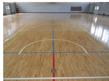
第2体育館床改修
