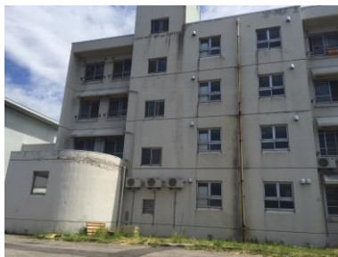
外壁老朽化状況
