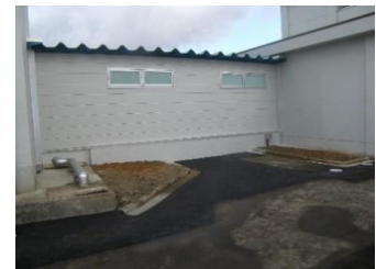
渡り廊下新営
