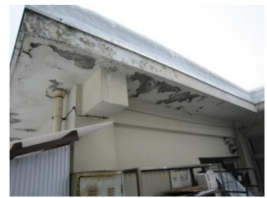
外部老朽状況
