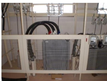
寄宿舍エアコン電源工事 （電気室変圧器新設）
