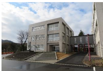
8 号館及び渡り廊下
