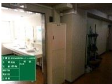
寄宿舍エアコン電源工事 （分電盤新設）
