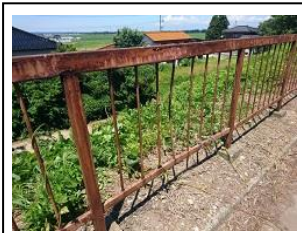
敷地境界フェンスの老朽化
