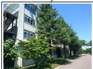
樹木の伸びすぎによる日射量低下
