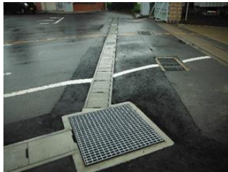
側溝及び排水柵整備
