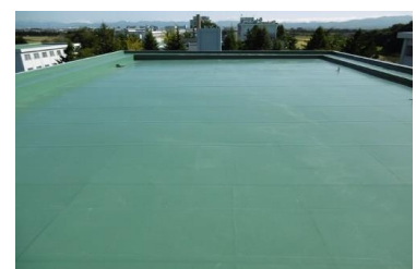
屋上防水改修
