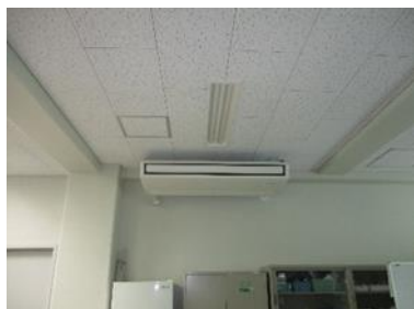
エアコン新設（実験室）
