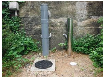
屋外排水管更新
