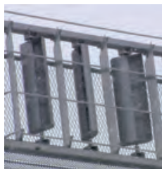
図2 地吹雪による視程障害対策用風車
