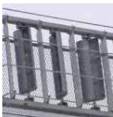
図2 地吹雪による視程障害対策用風車
