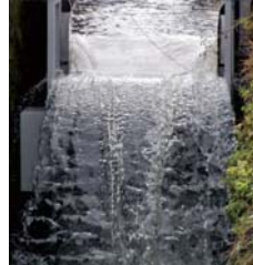
図3 落差工に設置したマイクロ水車と系統連系用機器
