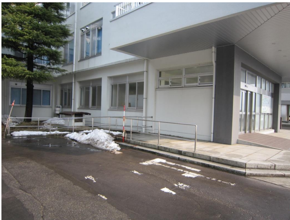
障がい者用スロープ
