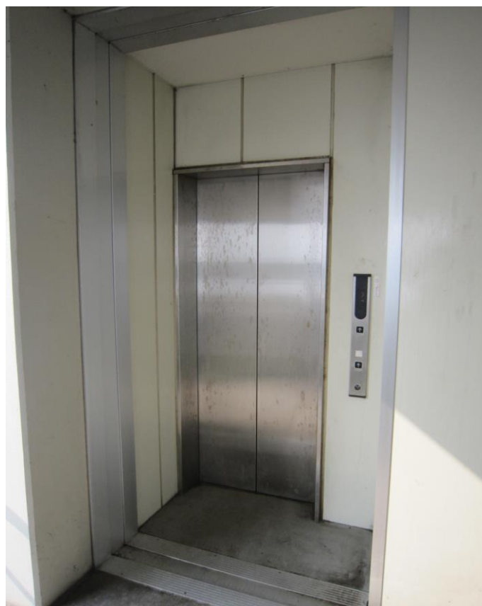
エレベーター
