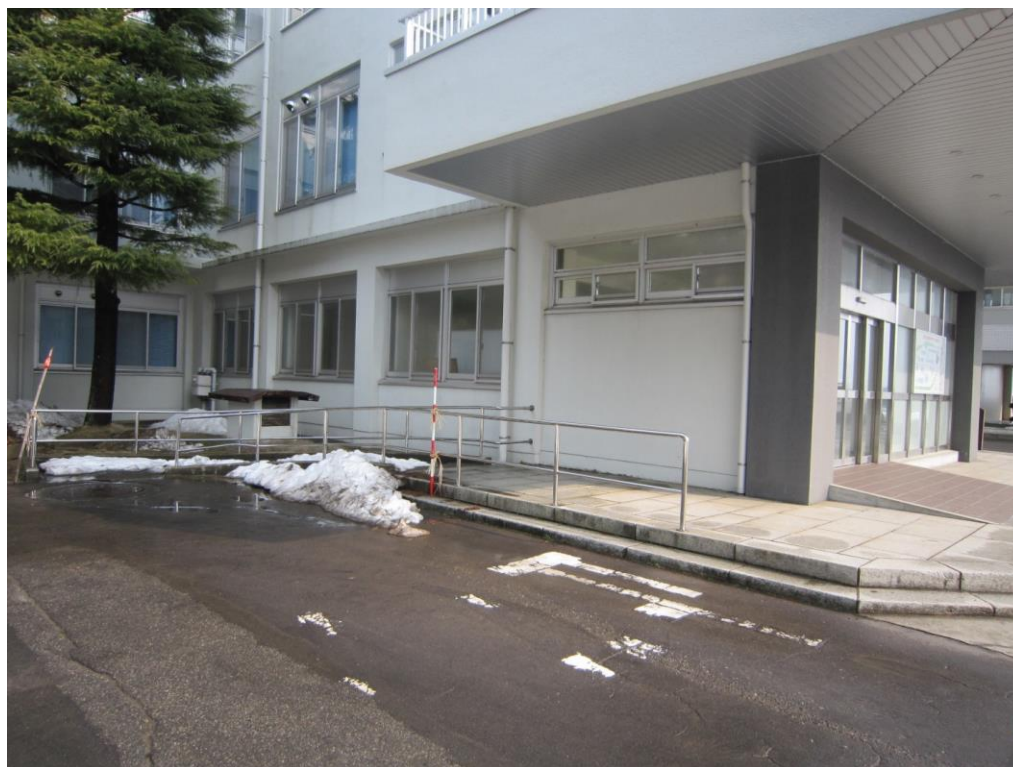
障がい者用スロープ
