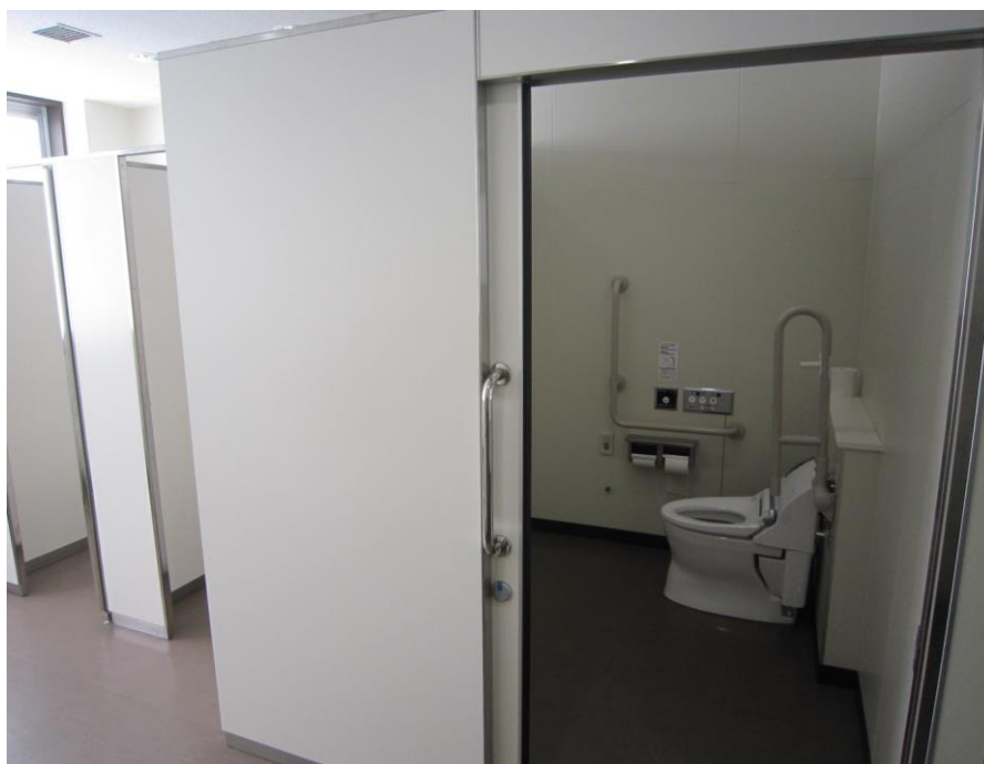
手摺り付トイレ
