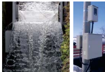
図3 落差工に設置したマイクロ水車と系統連系用機器
