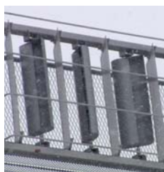
図2 地吹雪による視程障害対策用風車
