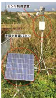
図2 赤川黒森樋門
