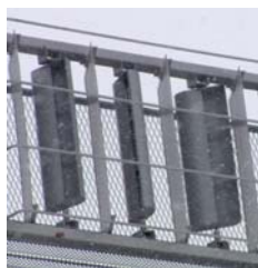
図2 地吹雪による視程障害対策用風車
