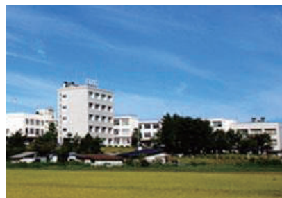
ビル、工場設備の エネルギー診断
